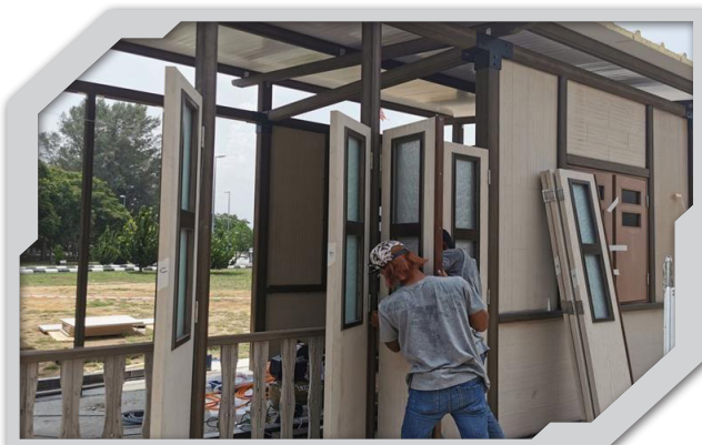
Kerja pemasangan komponen pintu dan tingkap WPC
