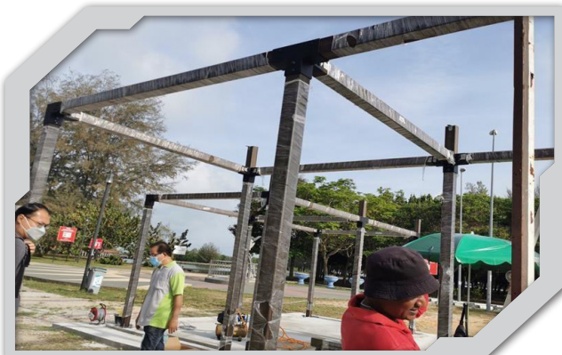
Kerja pembinaan dan pemasangan komponen structural daripada Metal - Reinforced WPC di Pantai Cahaya Negeri, Port Dickson
