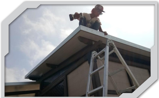
Pemasangan bumbung bagi kiosk makanan dan minuman WPC
