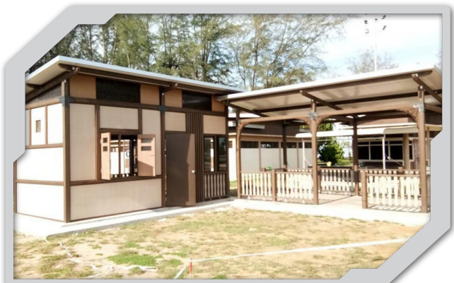
Bangunan kiosk makanan dan minuman telah siap dibina
